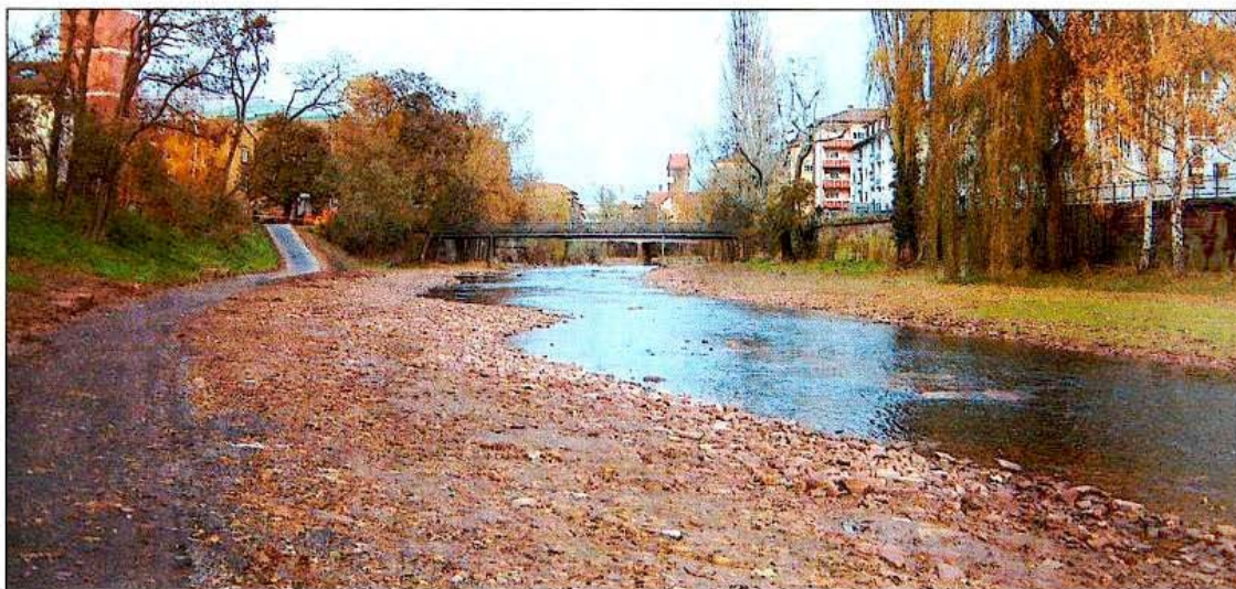
Die Geradlinigkeit verlassen: Aus einem befestigten, monotonen Flussabschnitt bei der Pforzheimer Werderbrücke haben Bauarbeiten ein naturähnliches Ufer gemacht.
